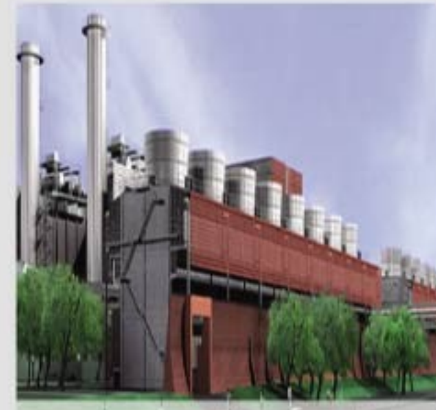
意大利TORVISCOSA 电站的全部消防系统 TORVISCOSA Power Plant, all the fire fighting systems, Italy
