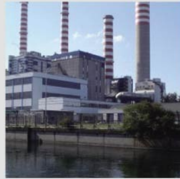
意大利EDI电站 EDI Power Plant, Italy
